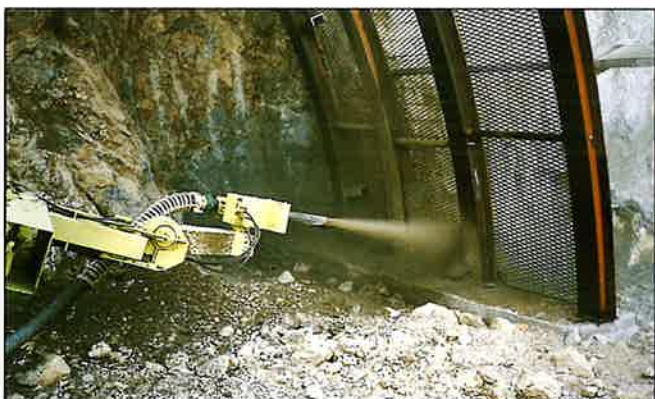
トンネル内の生コンクリート吹付現場
