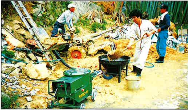
(壁土圧送現場)
