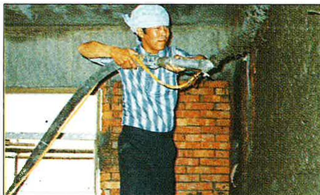
建設現場・モルタル吹付
