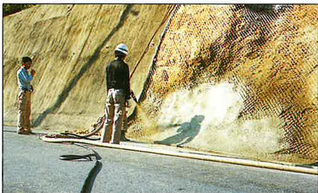
土木現場・モルタル吹付
