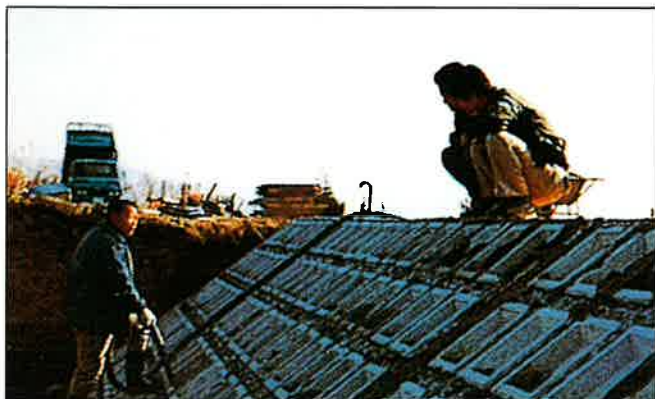
コンクリートブロックの目地づめ
