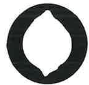
(他社製品のチューブの摩耗状態)
