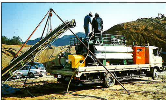
植生客土吹付プラント
